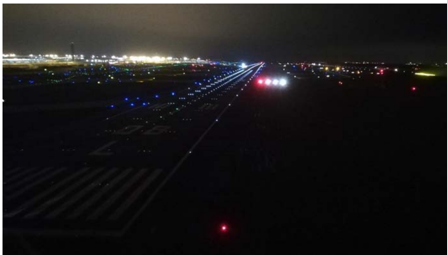
QFU 08L vu depuis la nacelle (à environ 40 mètres de hauteur)
