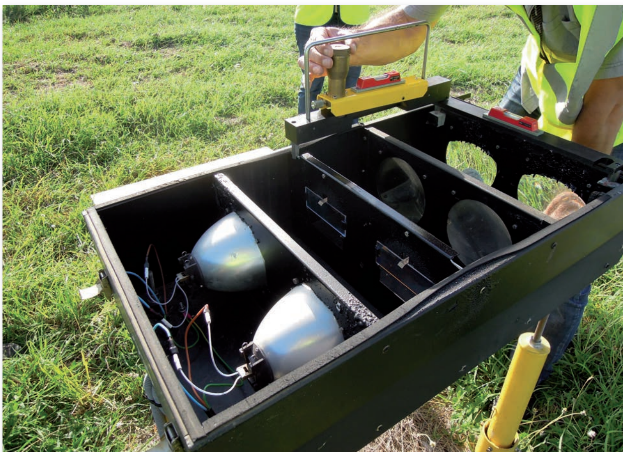
Vérification du calage de l'unité d'un PAPI à l'aide d'une alidade
