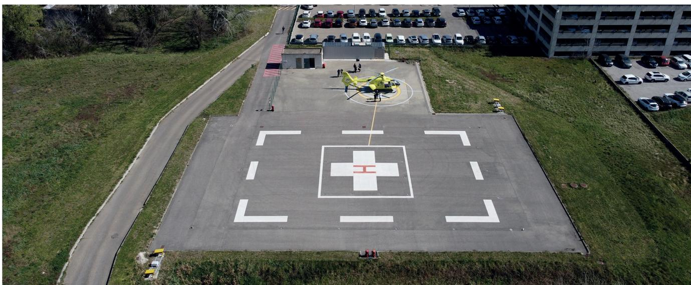
Figure 22: Hélistation dotée d'une voie de circulation en translation dans l'effet de sol - centre hospitalier d'Avignon
