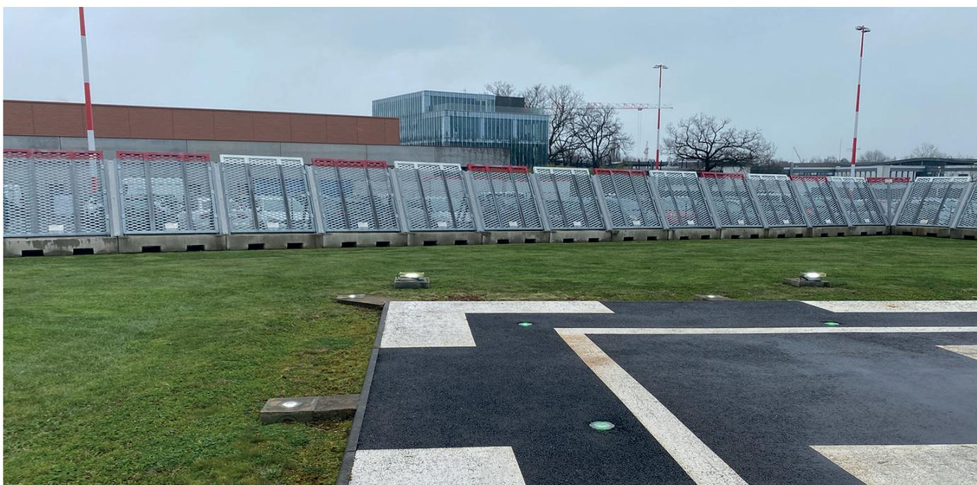
Figure 51: Barrières anti-souffle disposées entre une hélistation en surface et un parking - centre hospitalier de Rennes Pontchaillou
