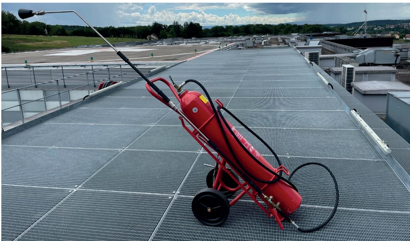
Figure 48: Extincteur à gaz carbonique de 20 kg
