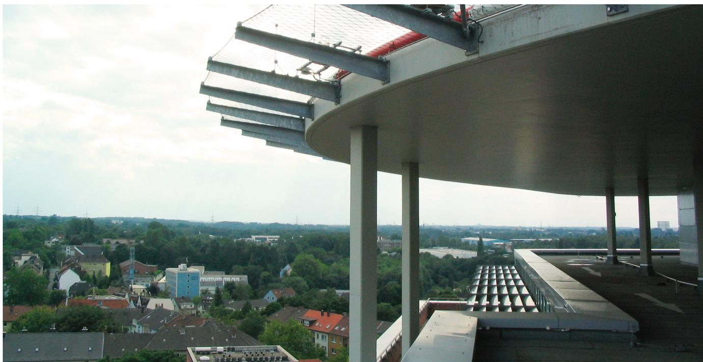
Figure 14: Aménagement d'un trou d'air sur une hélistation - centre hospitalier de Bochum (Allemagne)
