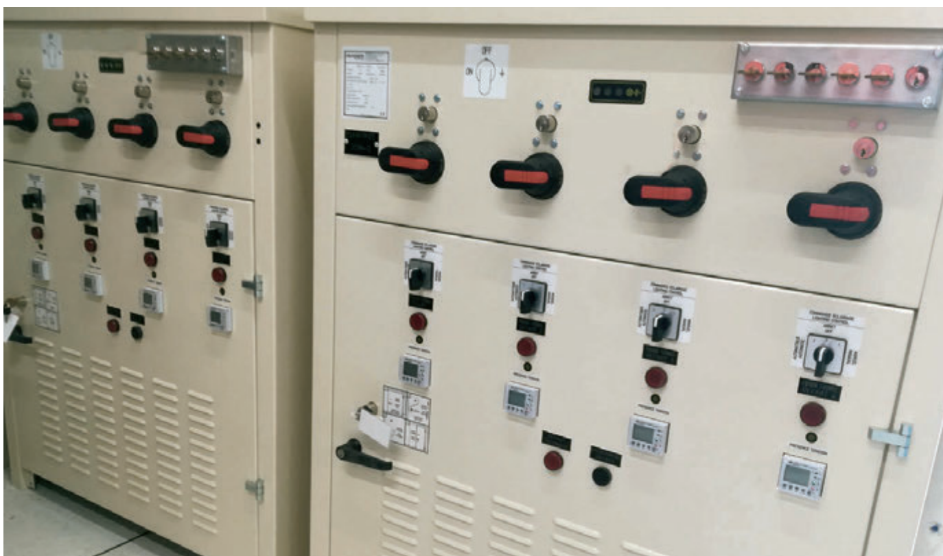
Figure 23: Tableaux de distribution électrique des panneaux et feux de protection de piste.
