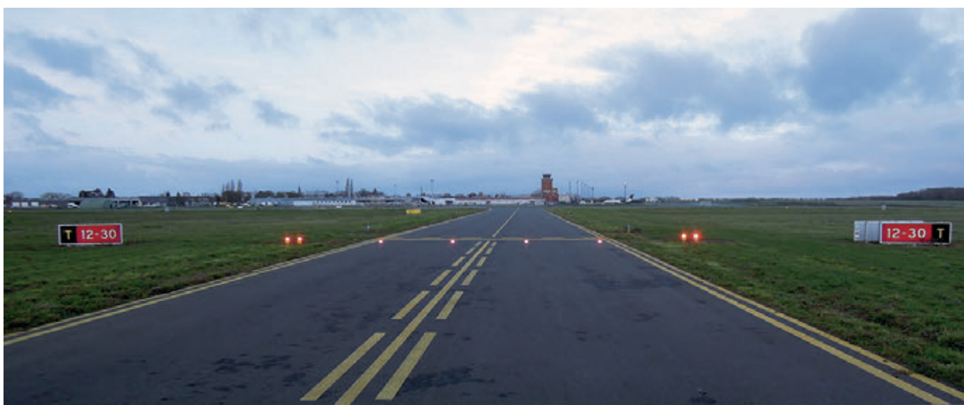
Figure 1: Barre d'arrêt – Aérodrome de Beauvais.
