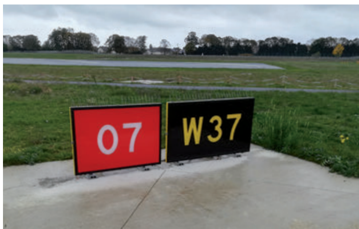
Figure 39: Panneaux de point d'attente avant piste.
