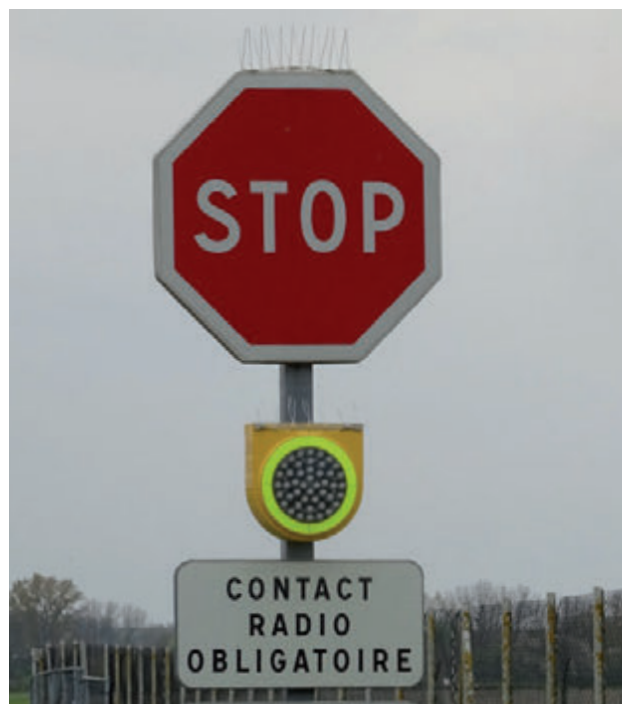
Figure 40: Feu de point d'attente sur voie de service Aéroport de Strasbourg Entzheim.
