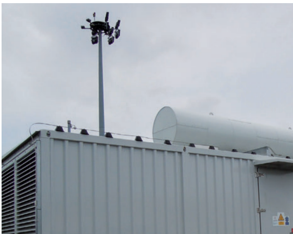
Figure 27: IEPF et système de capture – Aéroport de Toulouse Blagnac.
