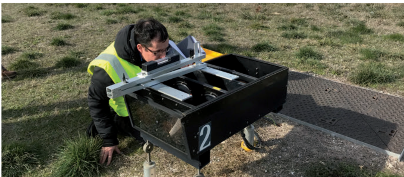
Figure 47 : Contrôle du calage en site d'une unité lumineuse d'un dispositif PAPI – Aérodrome d'Avignon.
