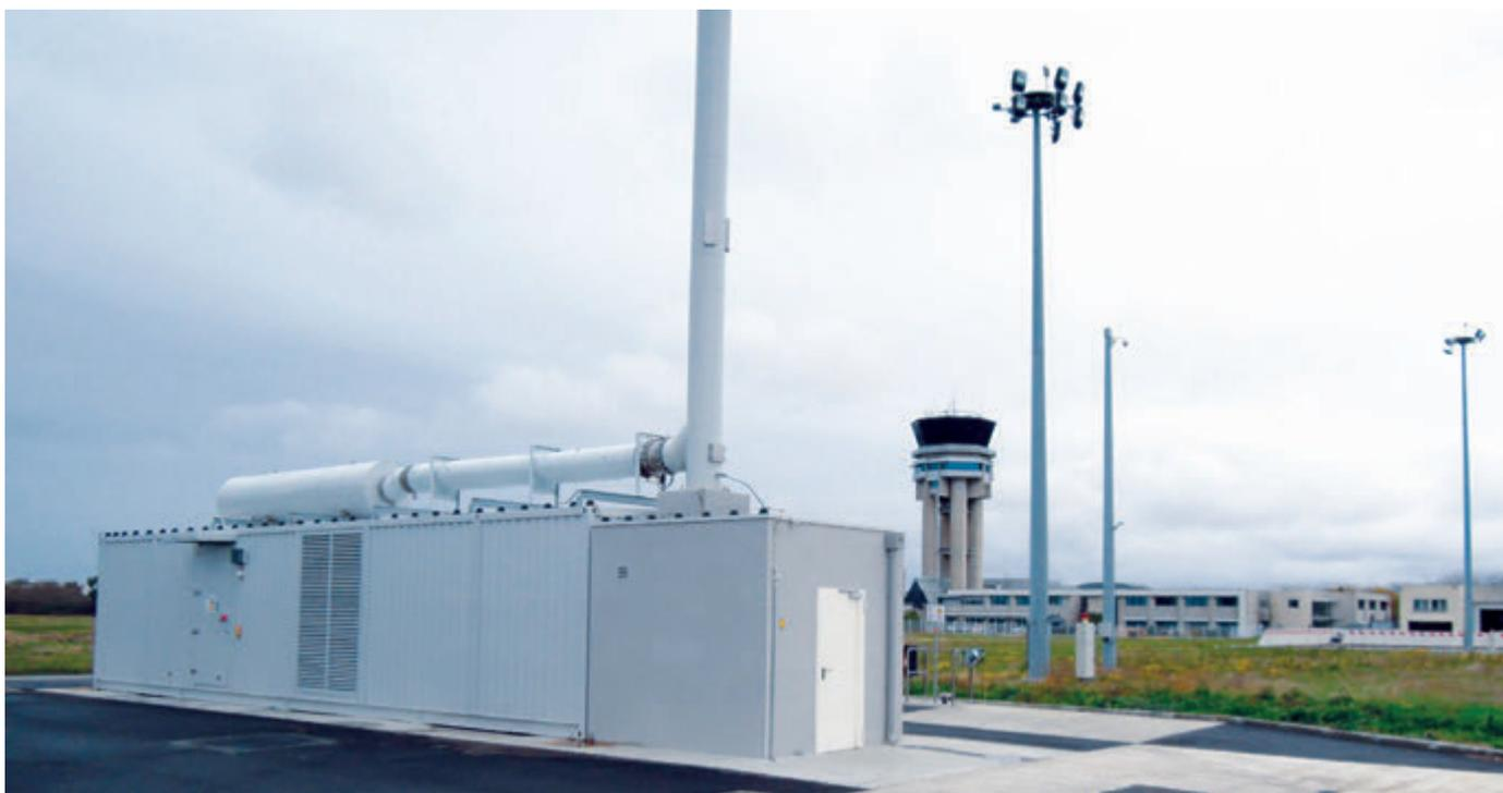
Figure 26: Système no-break en container – Aéroport de Toulouse Blagnac.
