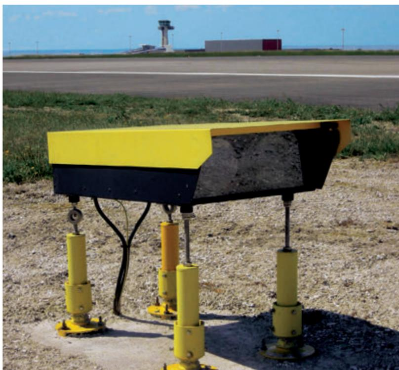
Figure 43: Unité lumineuse d'un dispositif PAPI - Aéroport de Châlons Vatry.
