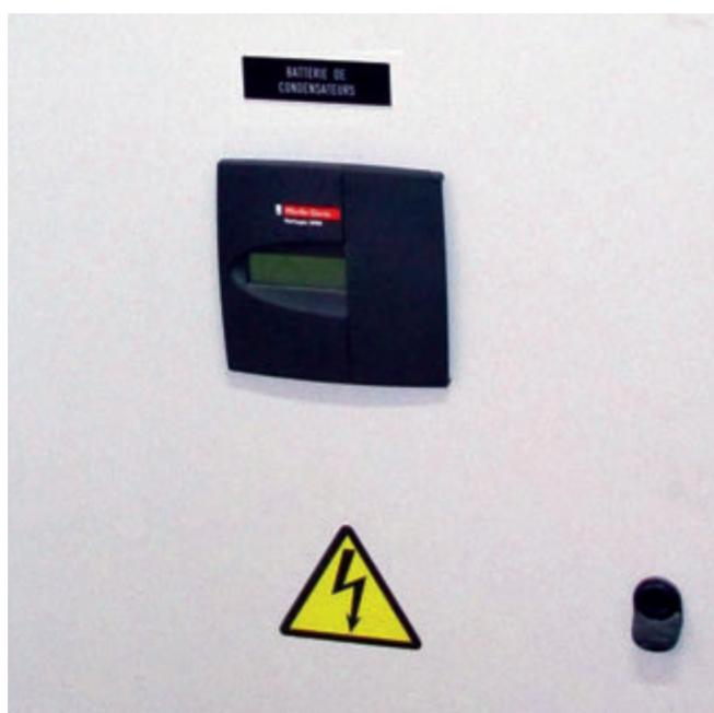
Figure 28: Batterie de condensateurs BT – Aéroport de Tahiti FAA'A
