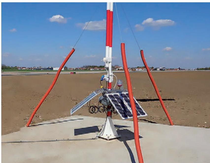
Figure 37: Massif support d'un indicateur de direction du vent - Aérodrome de Paris Orly.
