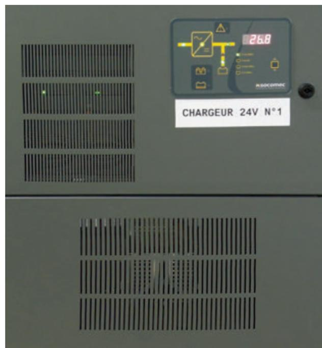
Figure 31: Redresseur/Chargeur 24 V DC - Aéroport de Toulouse Blagnac.
