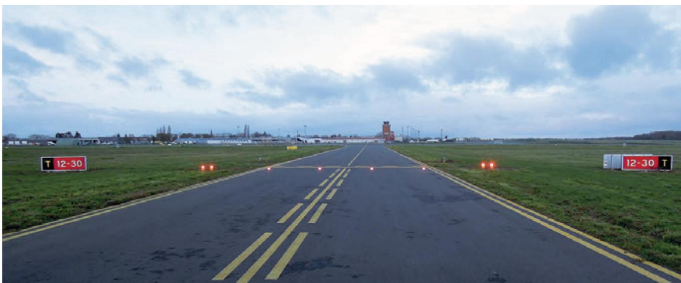
Figure 1: Barre d'arrêt – Aérodrome de Beauvais.
