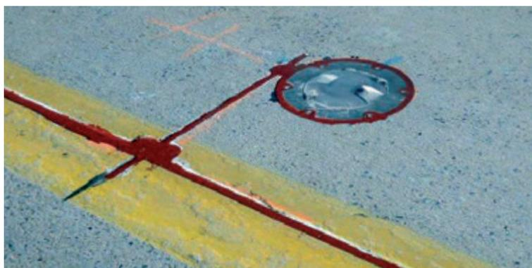
Figure 38: Saignée sur une piste en béton.
