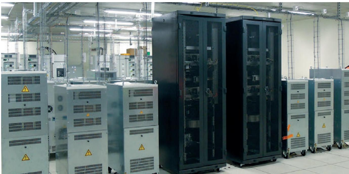
Figure 17: Poste électrique pour l'alimentation des dispositifs de balisage lumineux – Aéroport de Paris Orly.
