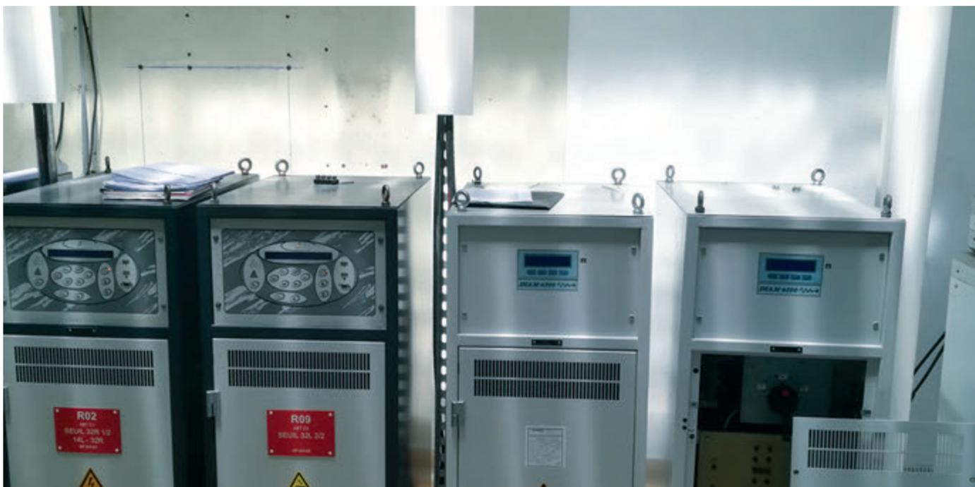
Figure 18: Poste électrique pour l'alimentation électrique des dispositifs de balisage lumineux – Aéroport de Toulouse Blagnac.
