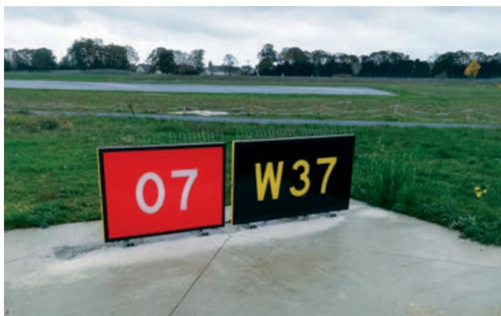
Figure 39: Panneaux de point d'attente avant piste.
