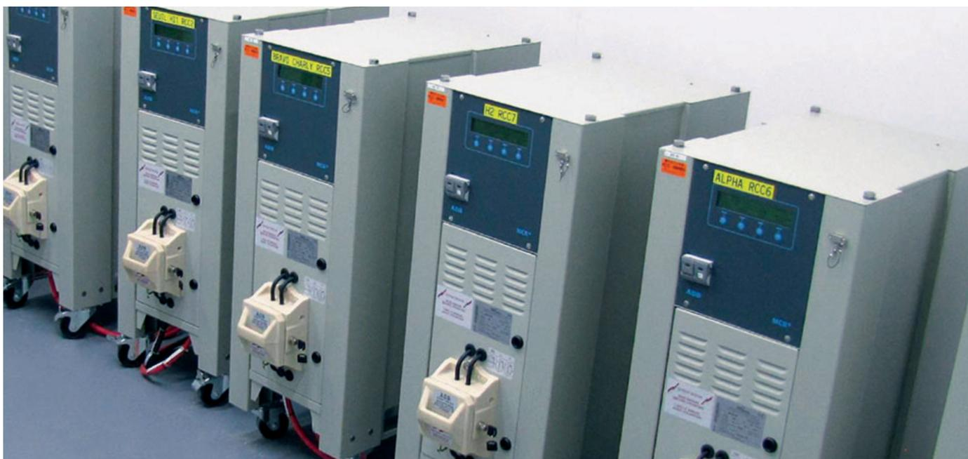
Figure 34 : Régulateurs à courant constant à thyristors – Aérodrome de Pointe A Pitre.
