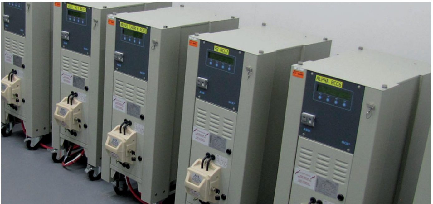
Figure 34: Thyristor CCR at Pointe à Pitre aerodrome.
