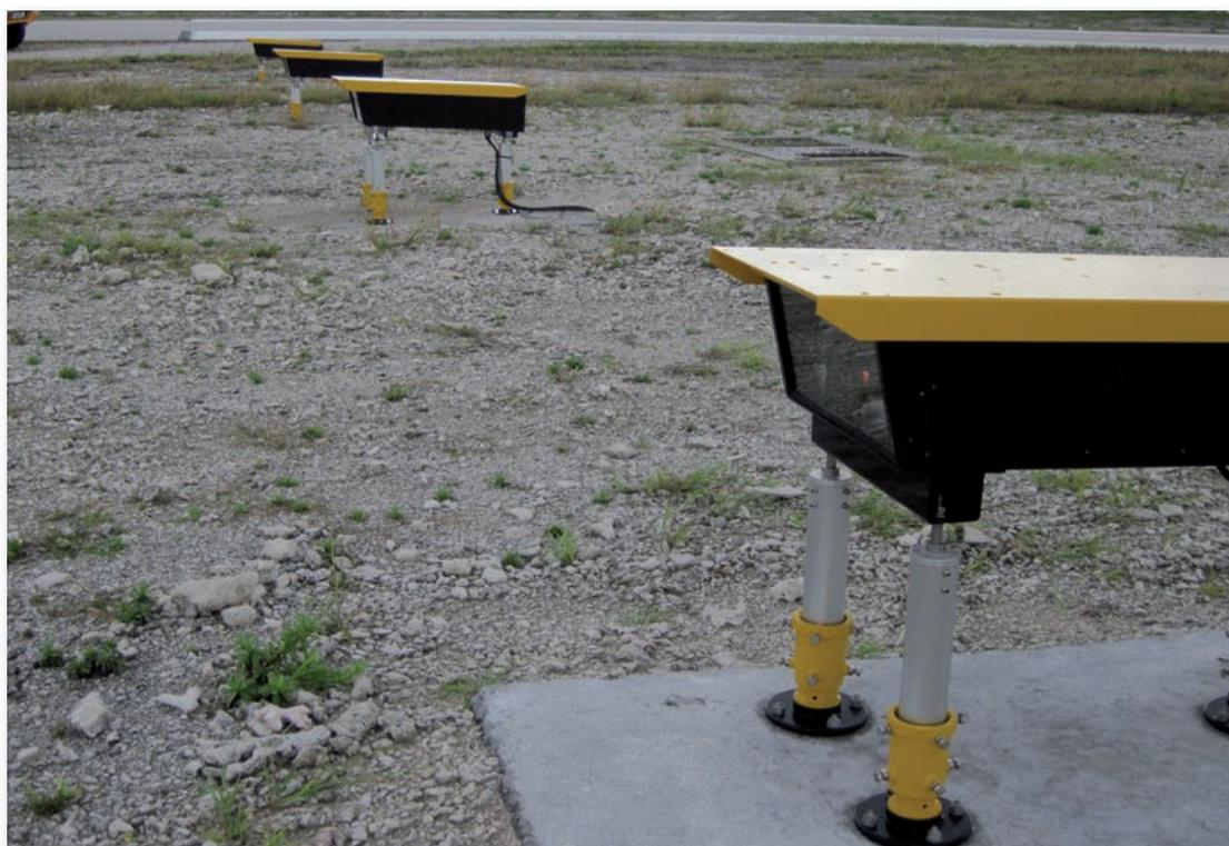
Enfin, afin d'assurer une perception optimale du signal du PAPI par les pilotes, les unités lumineuses sont calées en azimut parallèlement à l'axe de piste avec une tolérance de  $\pm 1^\circ$ , soit  $\pm 1,75\%$  (cf schéma ci-dessous).
