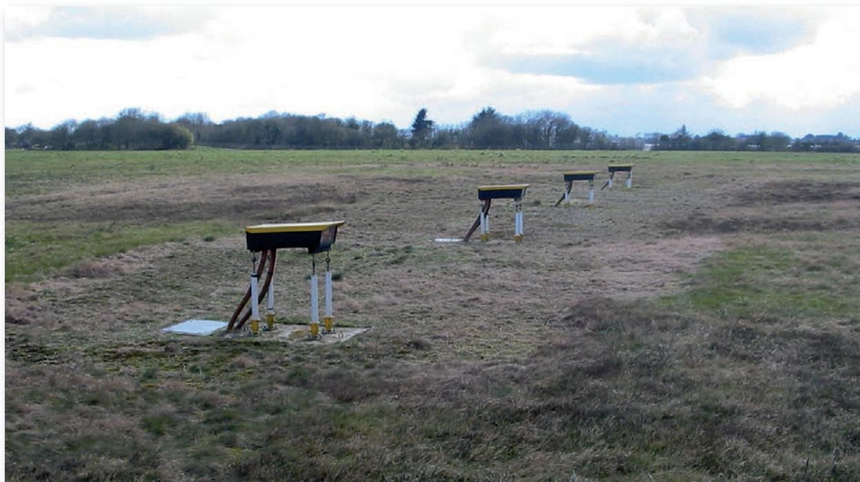
*Photo d'un PAPI installé sur un sol en pente. Pour compenser la pente et afin que les unités soient positionnées selon les tolérances décrites ci-dessus, chaque unité du PAPI est positionnée à une hauteur différente.*
