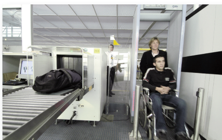
Portique d'inspection et de filtrage - Aéroport de Marseille-Provence
