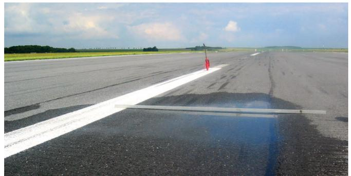
Figure 1 : Flache en partie centrale d'une piste
