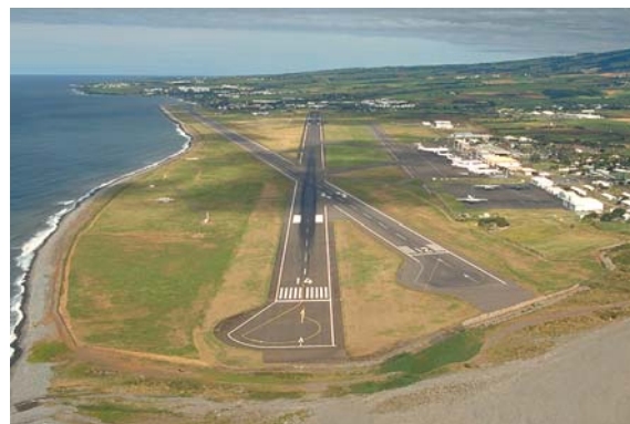
Les pistes sécantes de l'aéroport de Saint-Denis-Gillot
