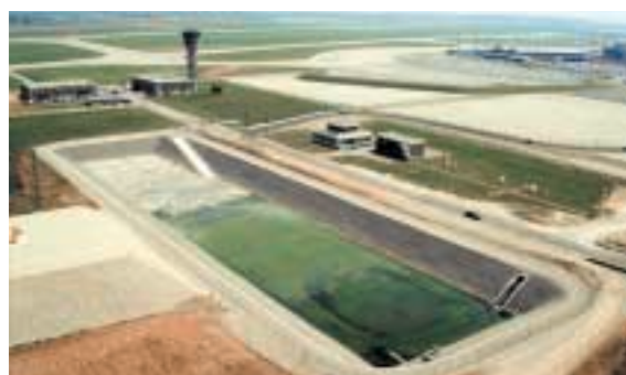
Bassin de décantation sur l'aérodrome de Lyon-Saint-Exupéry
