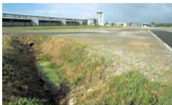
Fossé sur l'aérodrome d'Angers-Marcé
