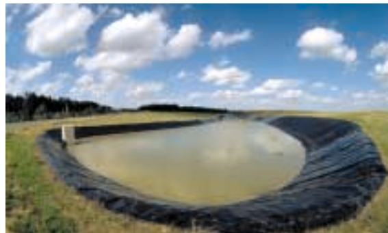
Bassin de rétention sur l'aérodrome d'Angers-Marcé
