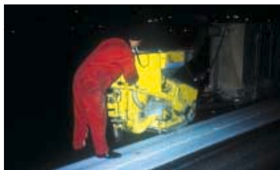
Opération de dégommage sur l'aéroport de Marseille-Provence
