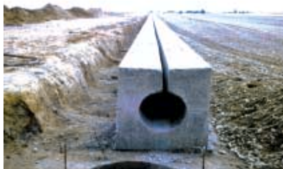
Caniveau à fente longitudinale de type satujo
