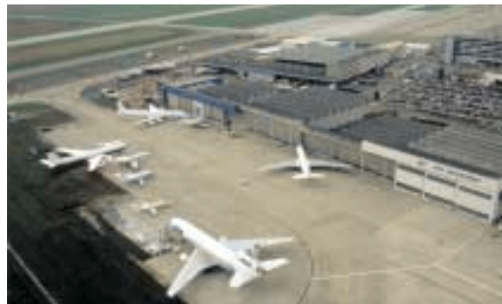
Zone de maintenance de l'aéroport de Bâle-Mulhouse
