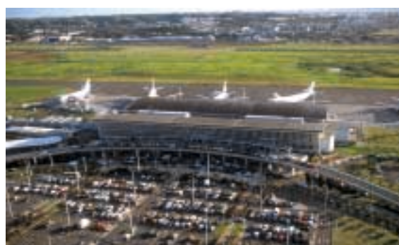
Aéroport de Pointe-à-Pitre-Le Raizet : parc de stationnement automobile et aérogare passagers
