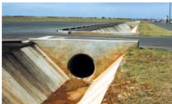
Fossé bétonné sur l'aérodrome de Roissy-Charles-De-Gaulle
