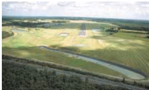
Bassin de rétention sur l'aérodrome d'Angers-Marcé
