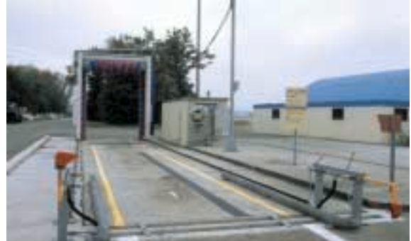
Aire de lavage des véhicules sur l'aérodrome de Bâle-Mulhouse
