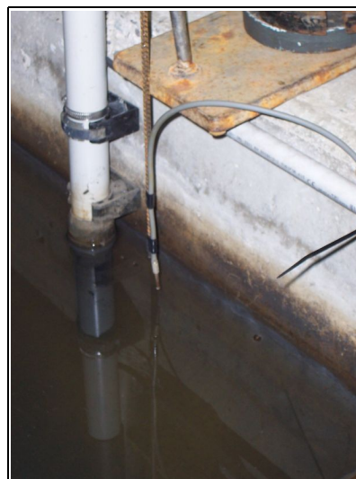
Figure 8 : Implantation du contact sec à côté de la sonde à ultrasons
