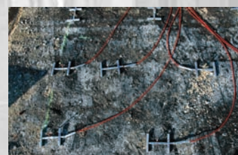
Capteurs d'élongation placés en base de grave bitume
