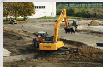
Travaux de terrassement pour la construction de la chaussée souple du STAC
