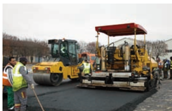
Mise en œuvre au finisseur et compactage de la grave-bitume
