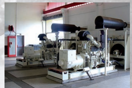
Centrale électrique de Cayenne
