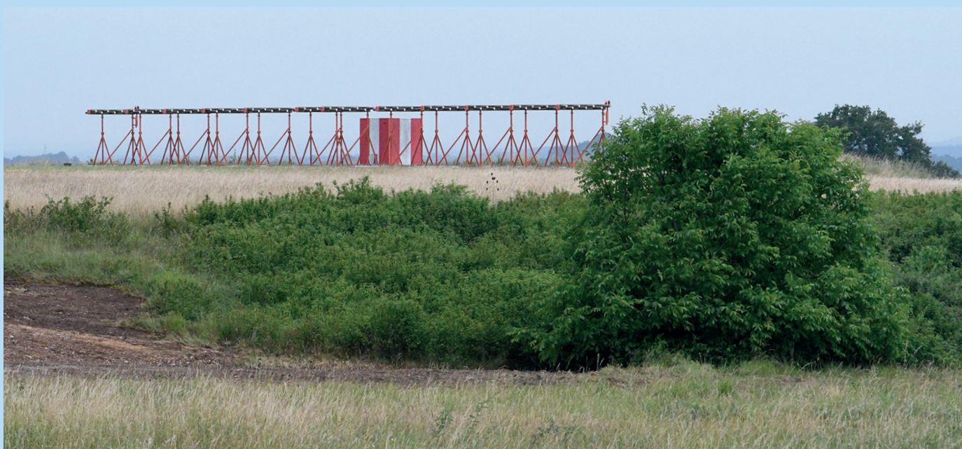
Figure 41 – Zone refuge en contrebas du seuil de piste et du localizer sur un aéroport.
