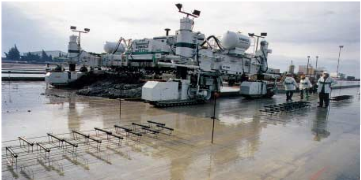
Marseille-Marignane : bétonnage d'une aire de stationnement
