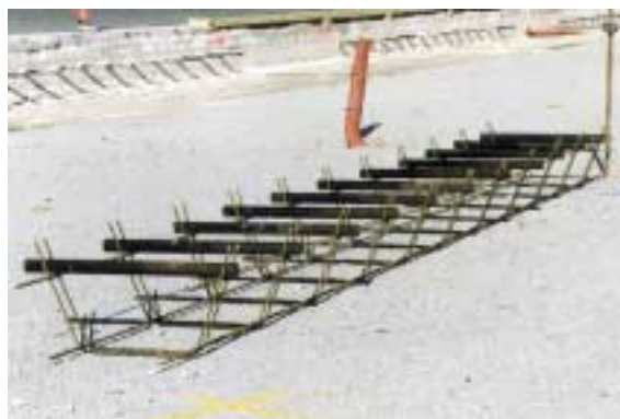
Panier support de goujons pour joint de retrait
