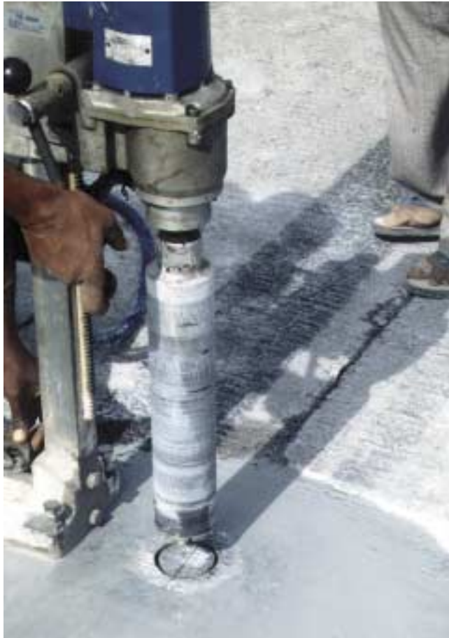
Carottage du béton
