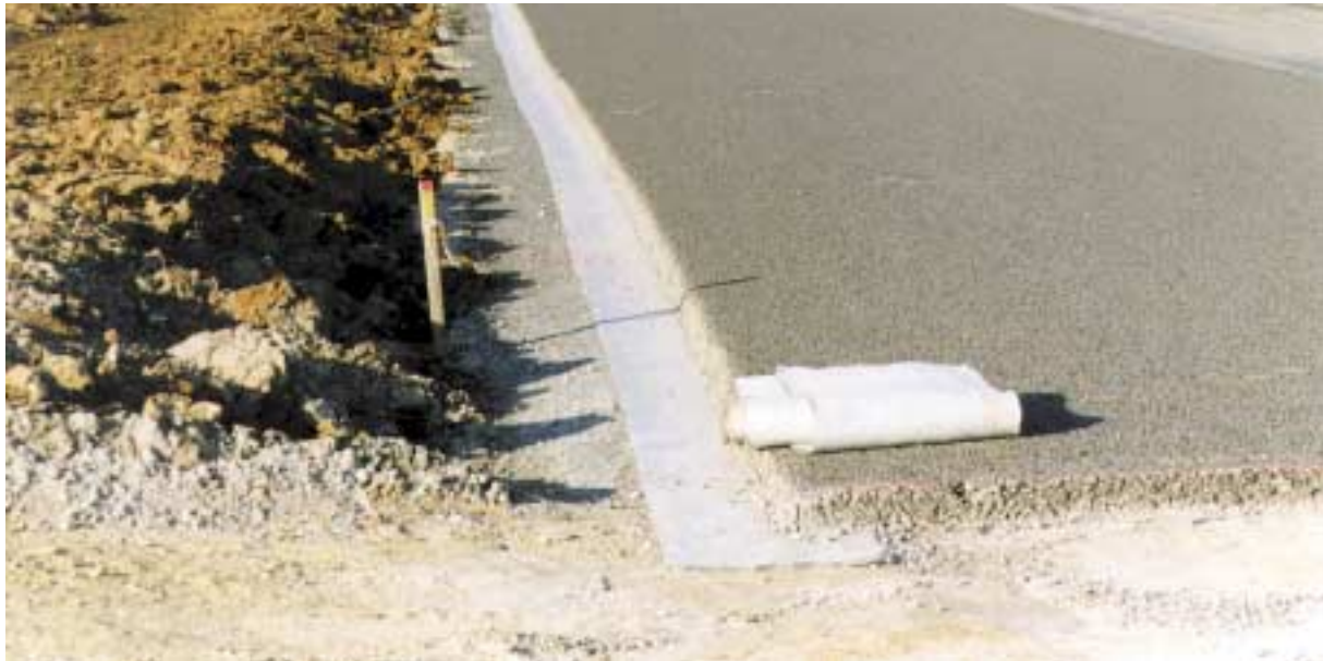
Sous couche de béton poreux
