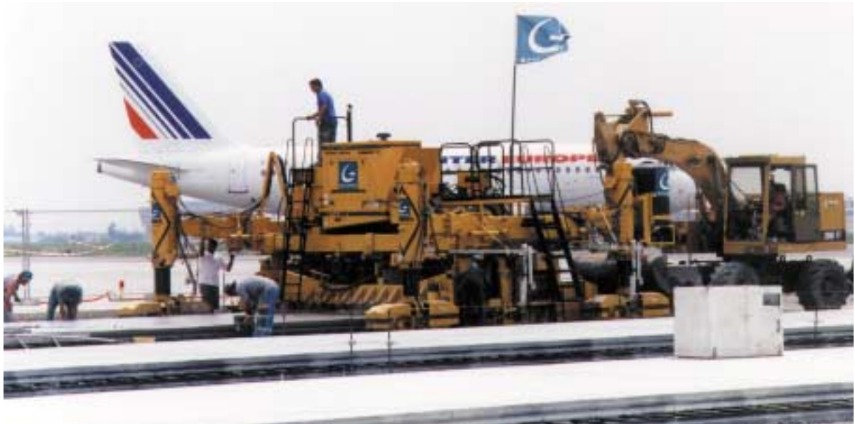
Aéroport de Paris-Charles de Gaulle : construction d'une aire de stationnement
