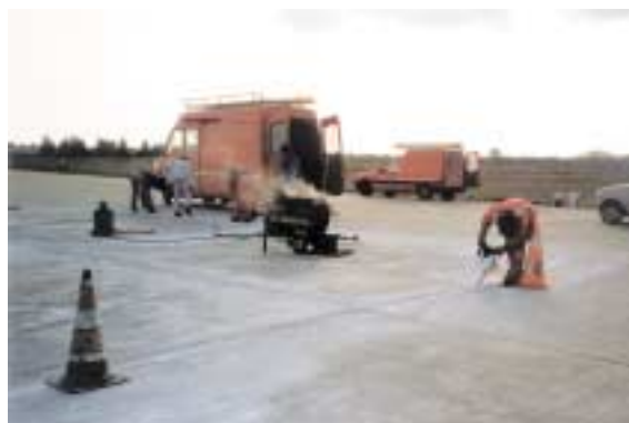
Remplissage des joints avec produit à chaud
