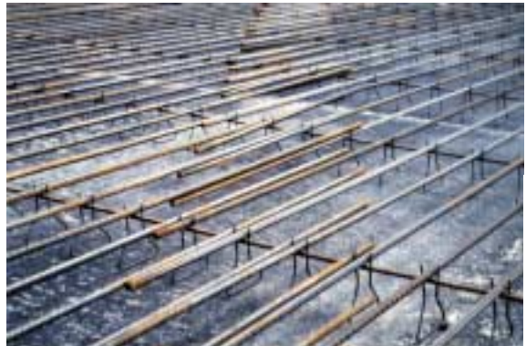
Chaussée en BAC - disposition des aciers
