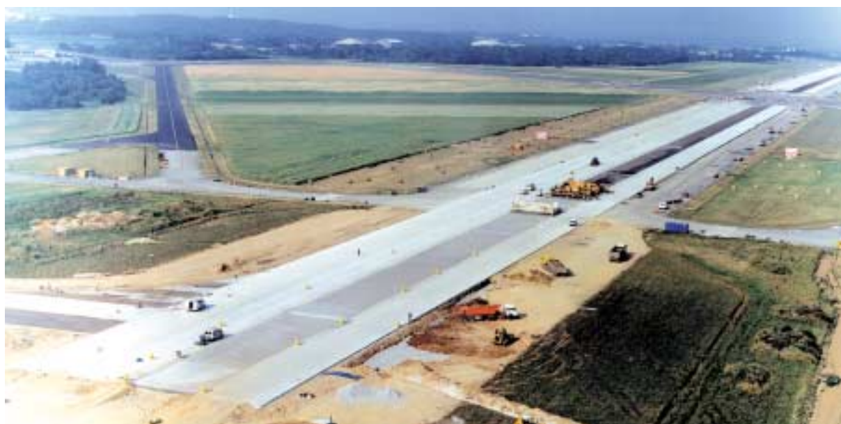
Aérodrome de Lorient-Lann Bihoué : vue générale du chantier
