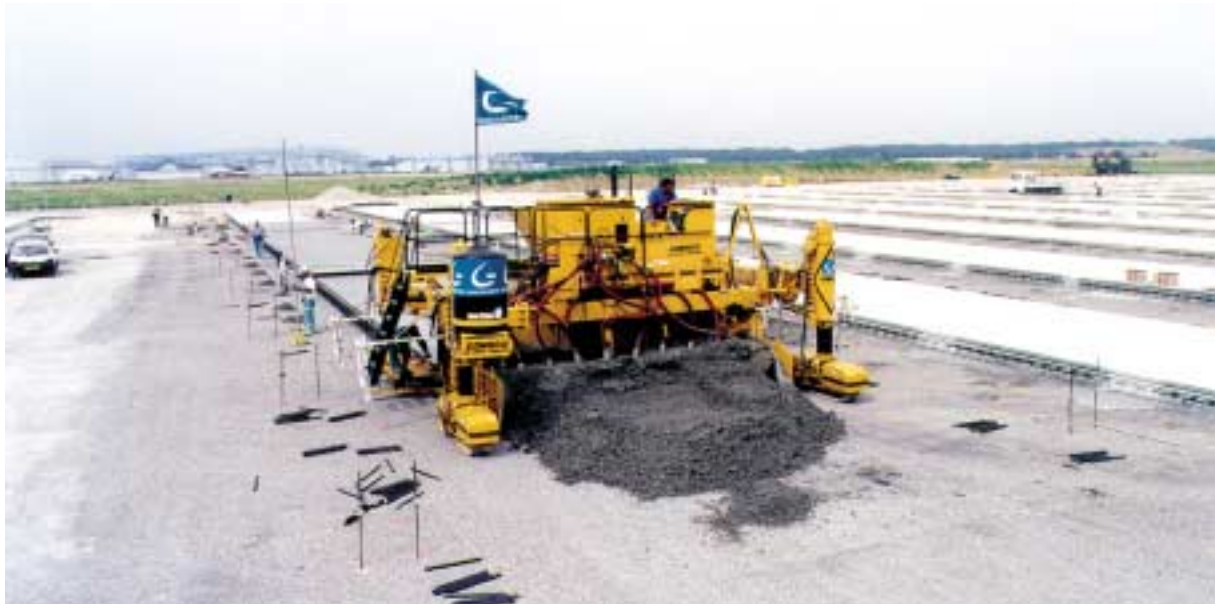
Aéroport de Paris-Charles de Gaulle : bétonnage d'une bande
