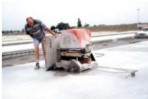
Sciage des joints de retrait
