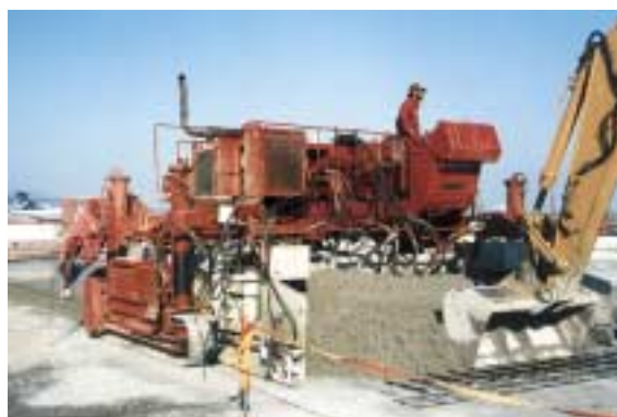
Aéroport de Paris-Charles de Gaulle : protection du panier par benne preneuse avant chargement de ce dernier
