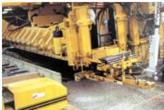
Système de mise en place automatique de goujons dans le joint longitudinal
