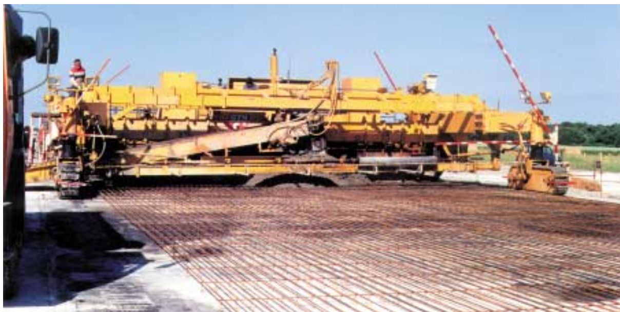
Photo 1 - Aéroport de Lorient-Lann Bihoué : reconstruction de la piste en B.A.C.
