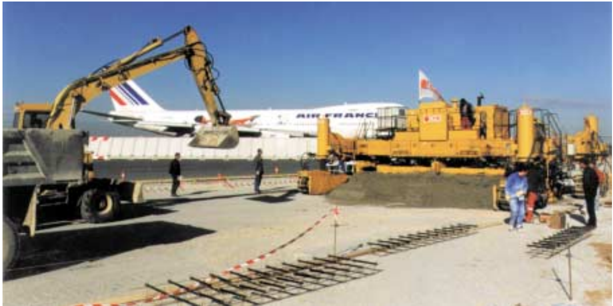
Aéroport de Paris-Charles de Gaulle : bétonnage d'une voie de circulation
