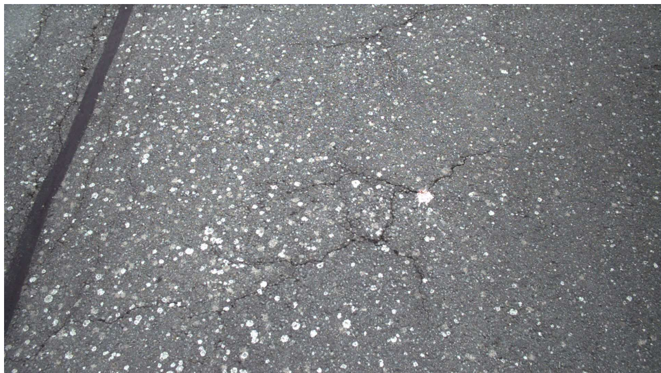
Un faïençage léger capturé avec l' IRCAN .
