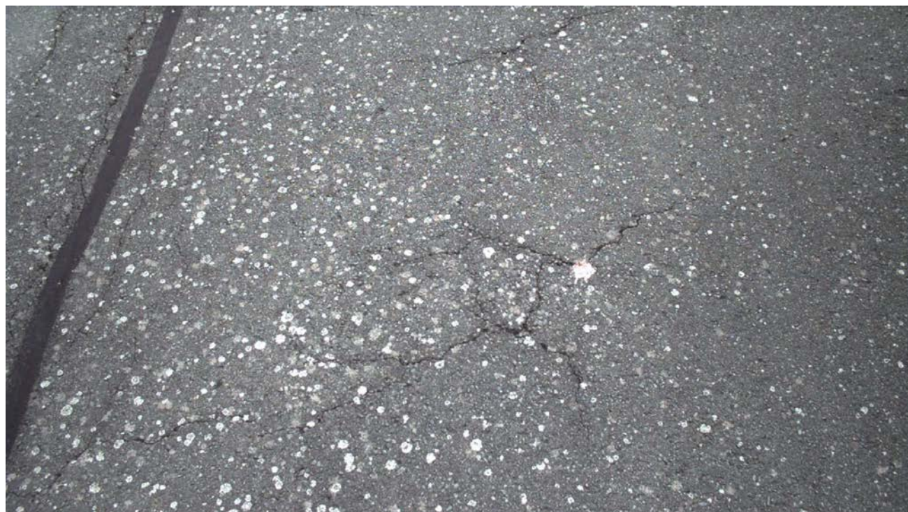
Un faïençage léger capturé avec l' IRCAN .
