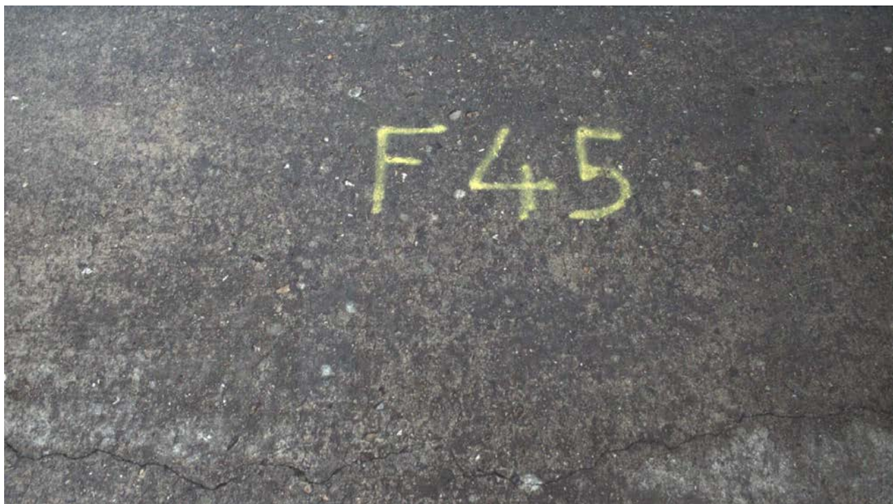
Une fissure de retrait détecté par l' IRCAN .
