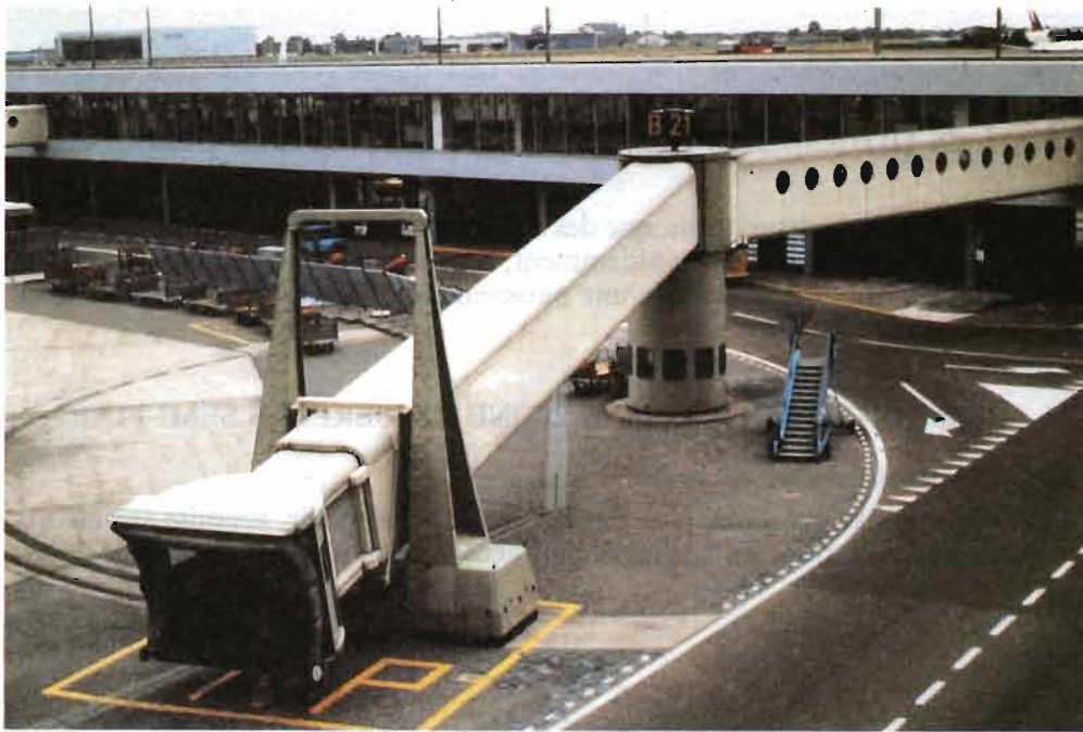
▲ Passerelle radiale et télescopique à Amsterdam Schiphol
