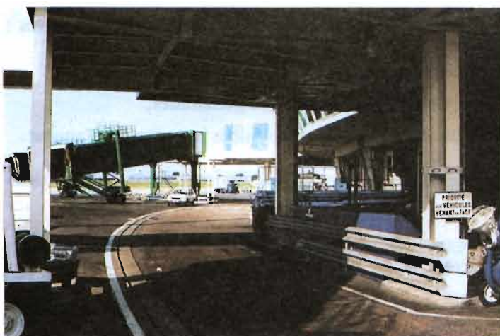
◀ A Lyon-Satolas un sens prioritaire de circulation a été institué à cause des poteaux de structure de la pré-passerelle qui réduisent la largeur libre de la voie de service.
