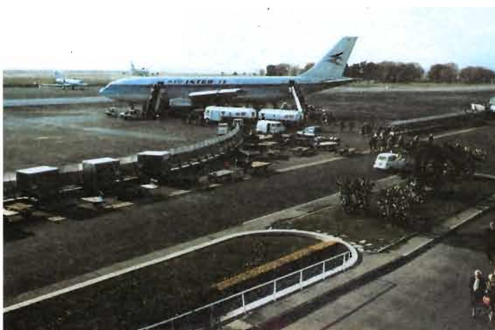
◀ Gêne sur la voie de service en l'absence de passerelle (Nice Côte d'Azur).
