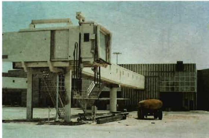
◀ Passerelle semi-fixe à Paris Orly Ouest Hall 4. Sur ce modèle les têtes ont une largeur de 5 m 50 et les barres d'arrêt sont désolidarisées des passerelles.
