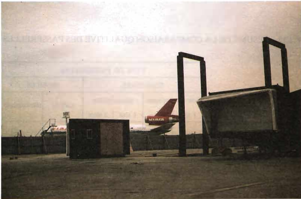
▲ Montage des passerelles semi-fixes du hall 4 à Paris Orly Ouest.
