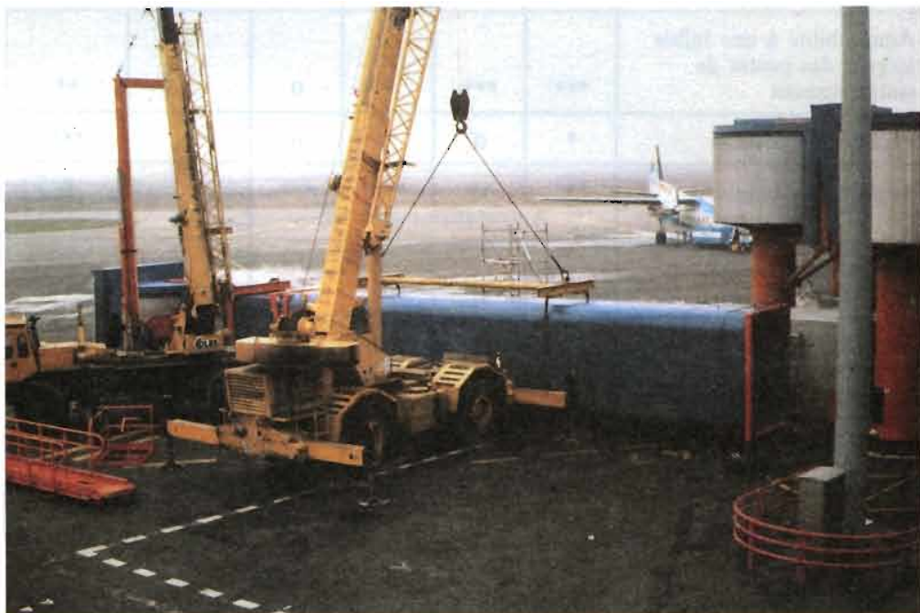
▲ Montage d'une passerelle mobile à Toulouse Blagnac.
