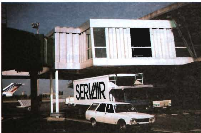
► Pour obtenir le gabarit de 3 m 70 il a fallu, à Toulouse-Blagnac, modifier l'habillage des pré-passerelles.
