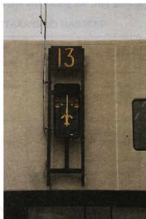
◀ Barre d'arrêt robotisée installée à Paris CDG Aériport n° 2.
