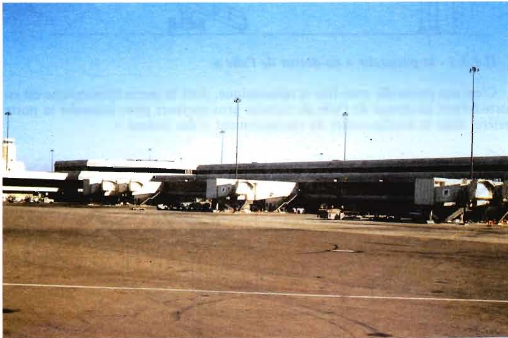
▲ Passerelles semi-fixes et télescopiques à San Francisco-International (1 ou 2 passerelles selon les postes de stationnement).
