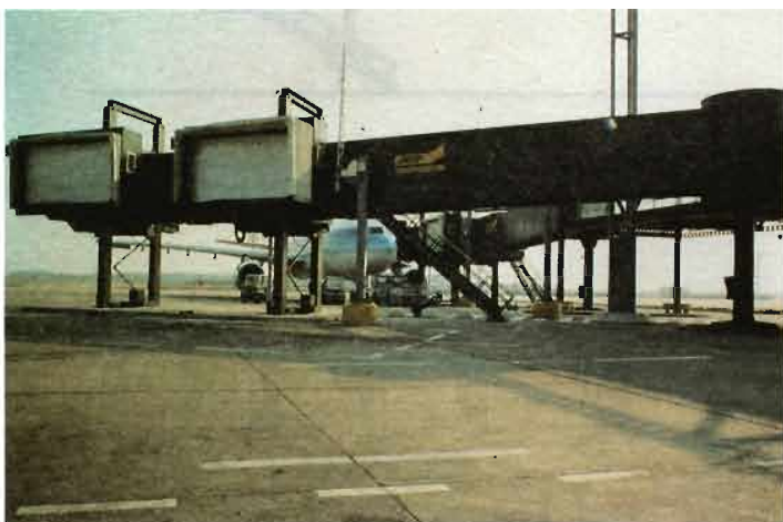
◀ Passerelle semi-fixe à Paris Orly Ouest Hall 4. Sur ce modèle les têtes ont une largeur de 5 m 50 et les barres d'arrêt sont désolidarisées des passerelles.
