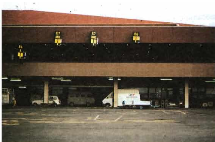
◀ Système optique de guidage à Toulouse-Blagnac.
