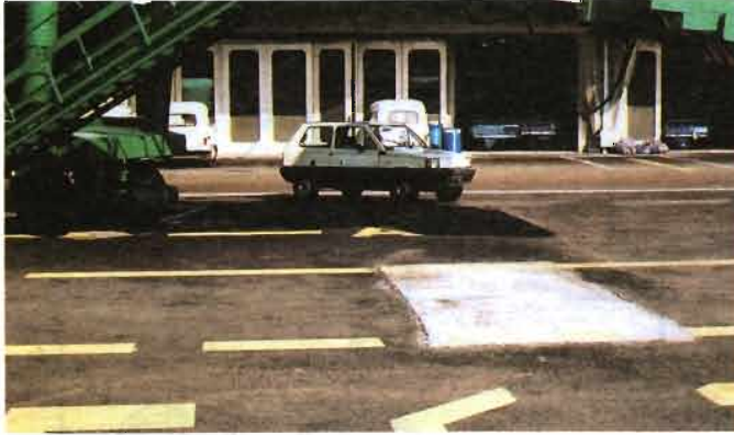
◀ Au niveau des zones de stationnement des essieux, une structure bétonnée a remplacé la chaussée souple à Lyon-Satolas.
