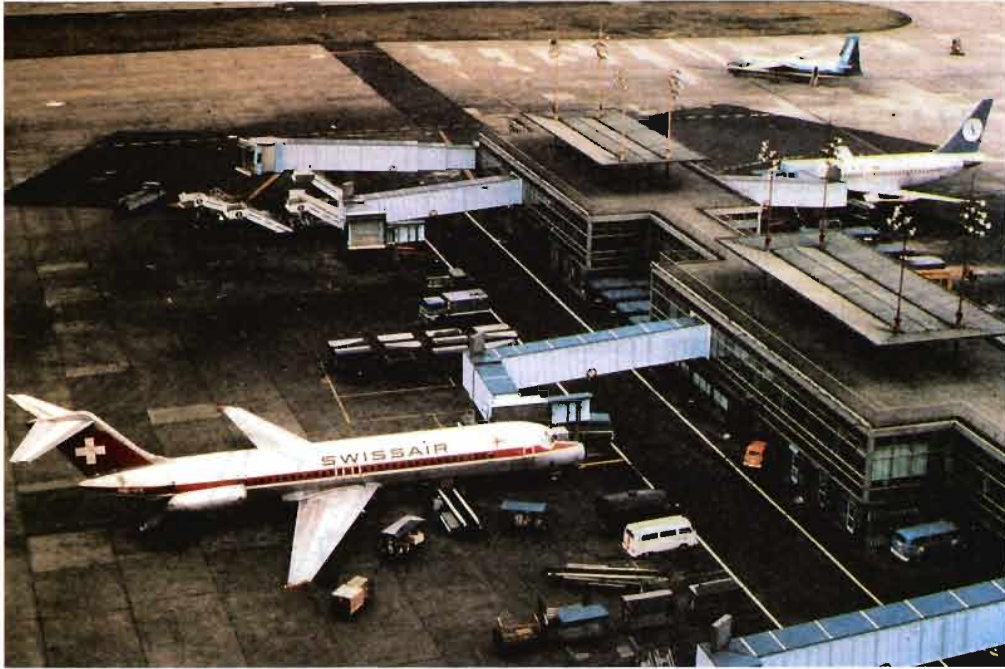
▲ Passerelles semi-fixes et télescopiques à Bruxelles - National
