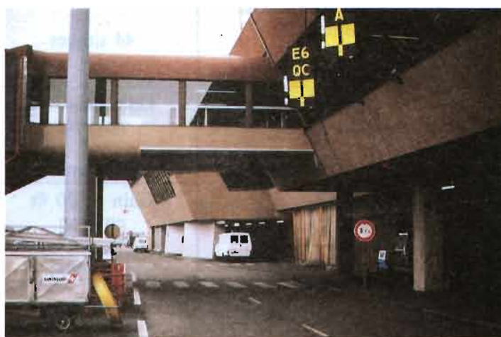
◀ A Lyon-Satolas un sens prioritaire de circulation a été institué à cause des poteaux de structure de la pré-passerelle qui réduisent la largeur libre de la voie de service.
