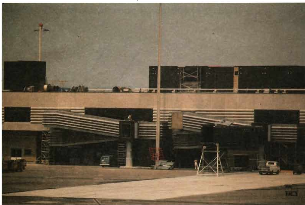
A Zürich-Kloten la répartition des passagers arrivant et partant se fait au niveau des pré-passerelles inclinées.
