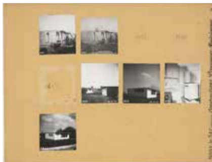
Photothèque du ministère de la Reconstruction et de l'Urbanisme, « Noisy-le-Sec. Chantiers d'expérience. 2. Maisons américaines » - Désassemblage des photographies en page 9, Archives nationales, F/14/18265/5.
