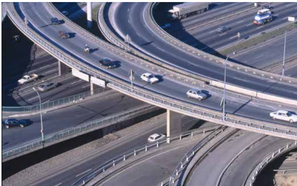
Fig. 1 : Echangeur de Bagnolet, 1978. Photothèque de la direction des Routes, Albert Bérenghier
