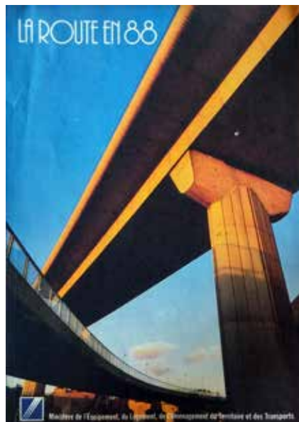
Fig 5. Rapport d'activité de la direction des Routes «La route en 1988» Viaduc de Saint-Maurice, A4, 1986. © Photothèque de la direction des Routes Albert Bérenquier
