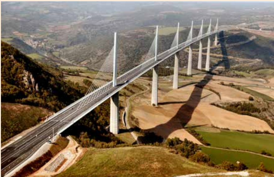
Viaduc de Millau en hélicoptère ©SETRA Gérard Fourquet
