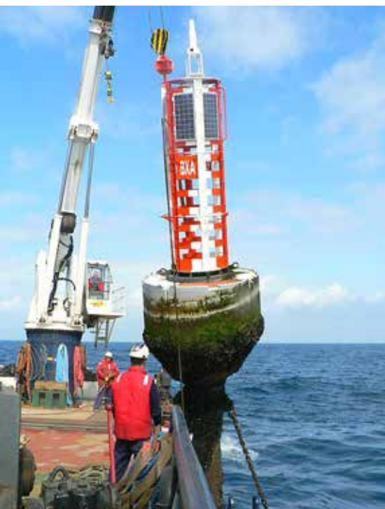
Relevage d'une bouée de nouvelle génération
