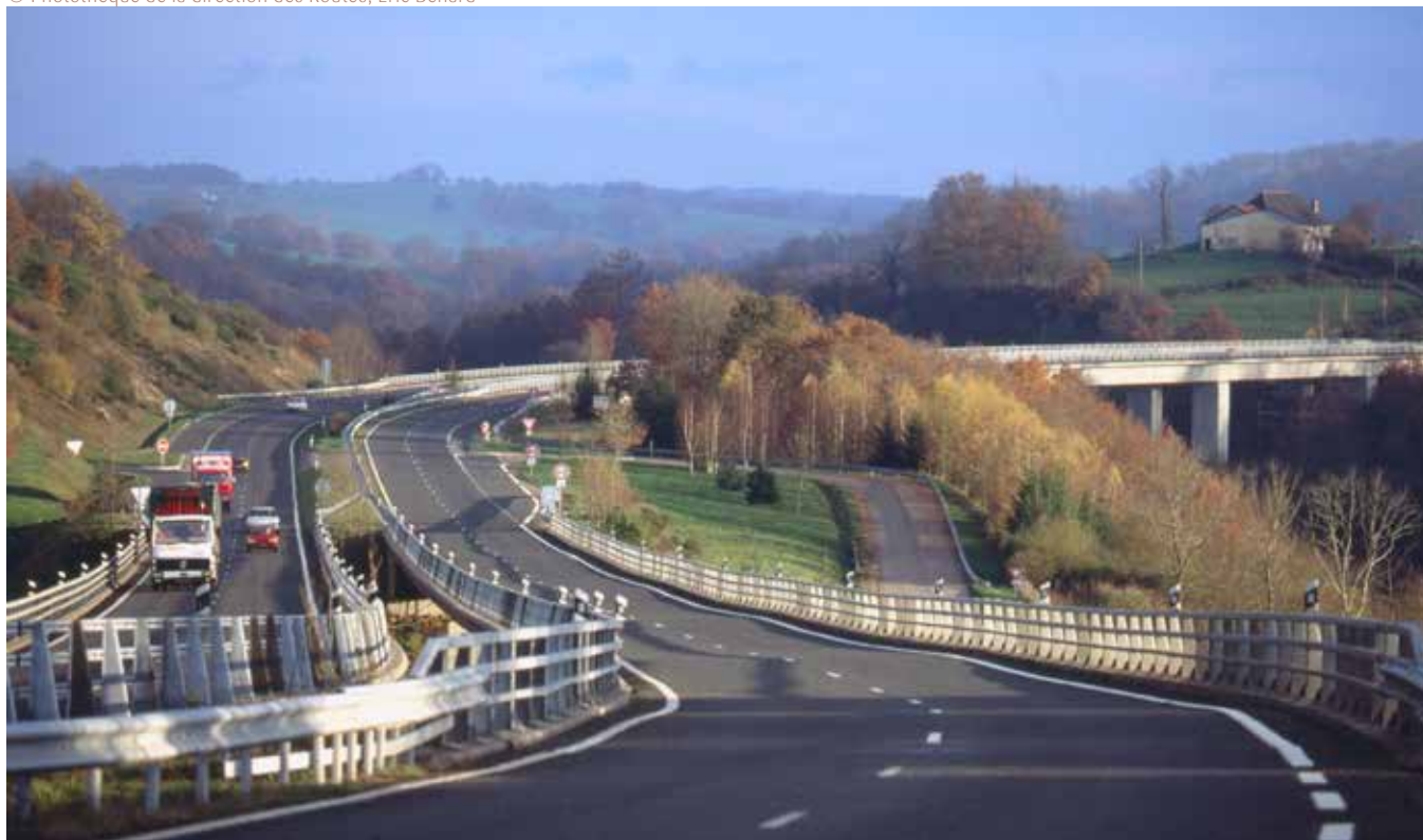
Fig. 14 : RN7 - Allier - Déviation nord de Moulins, 1992. © Photothèque de la direction des Routes, Eric Bénard
