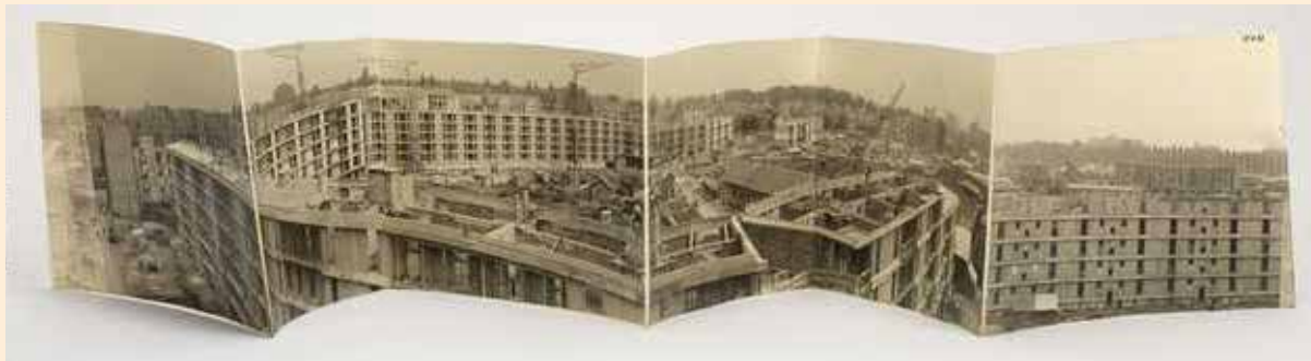
Bureau des chantiers d'expérience, vue panoramique de la cité Rotterdam, à Strasbourg, août 1952, assemblage de tirages argentiques, noir et blanc, 15 x 118 cm, Archives nationales (France), 19790651/2.
