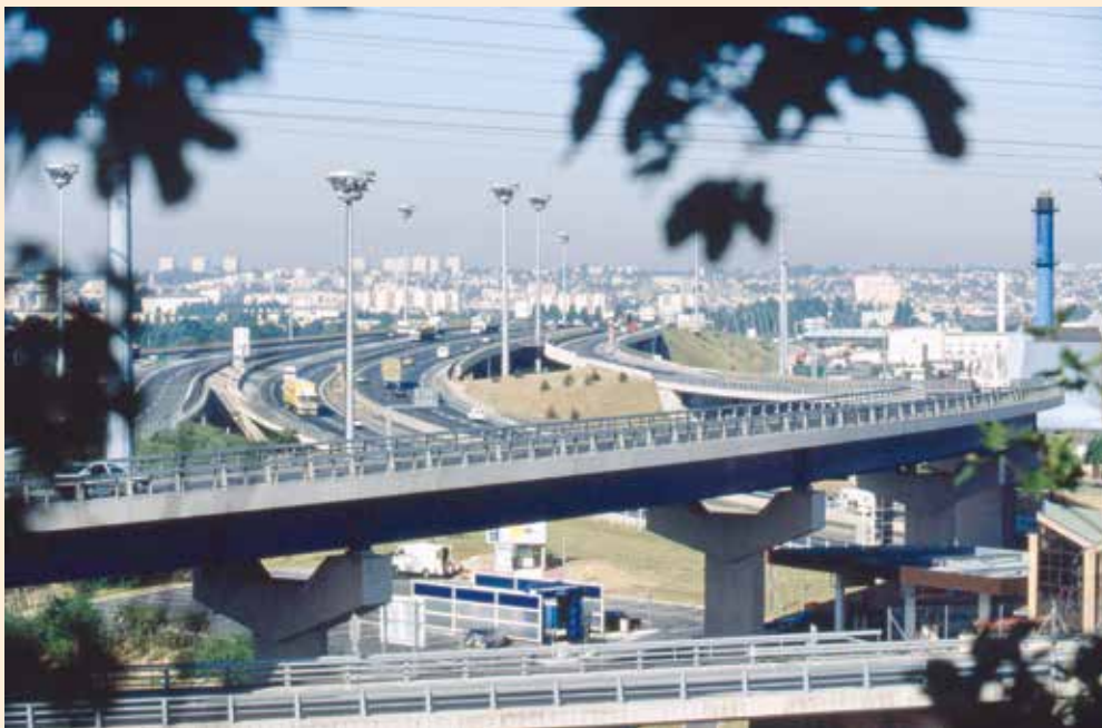
A86 - Carrefour Pompadour : échangeur, 1992. © Photothèque de la direction des Routes, Eric Bénard
