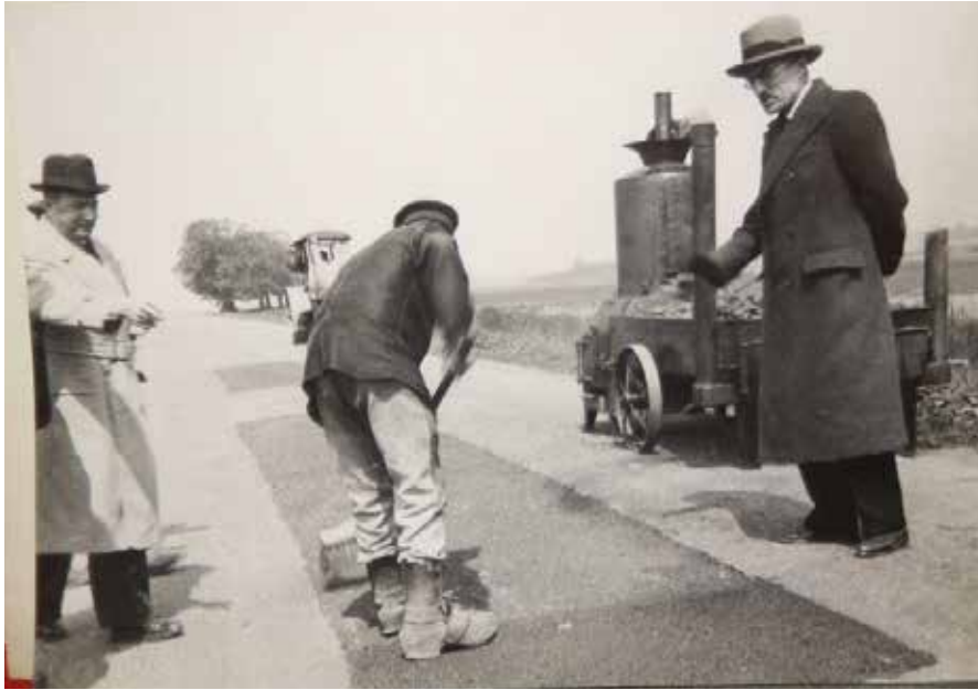
Jacques Bouulloche, directeur des routes, au cours d'une inspection de travaux routiers en 1937
