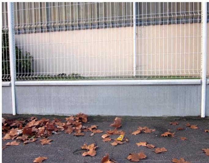
*Soubassement en plaques béton préfabriquées*
