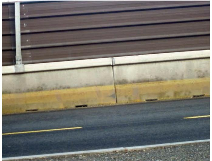
*Glissière de sécurité en bloc béton préfabriqué*
