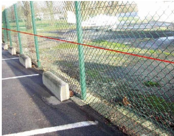
Position d'installation d'une fibre optique sur un grillage en rouleau
