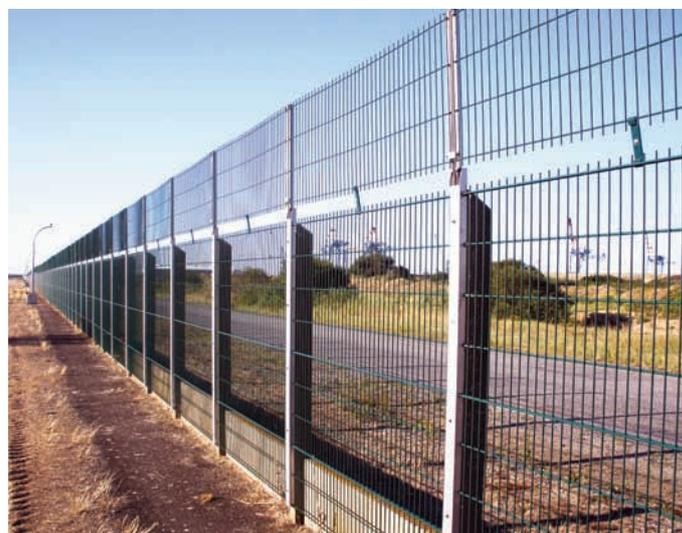
Clôture en panneaux à détection de coupure avec des bavolets détecteurs
