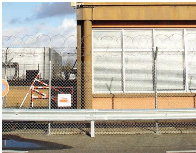
*Glissière de sécurité métallique protégeant la clôture le long d'une voie de circulation*
