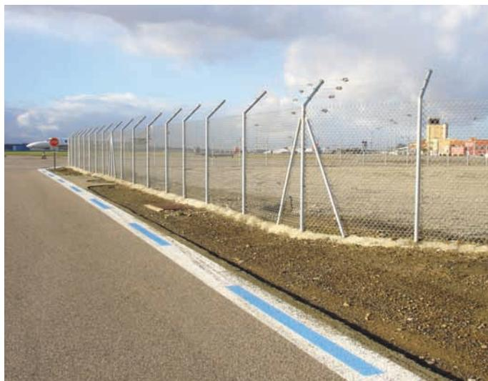
Grillage simple torsion équipée de bavolets avec fils de ronce
