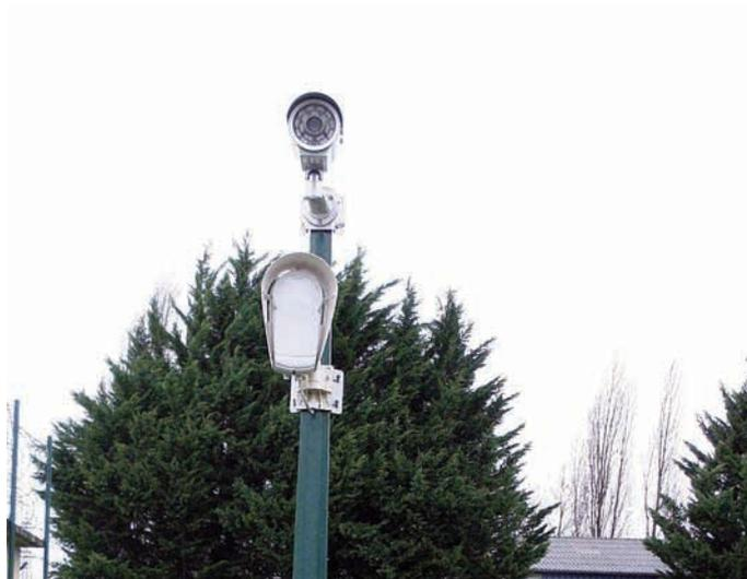
Détecteur infrarouge/hyperfréquence monté sur un mat
