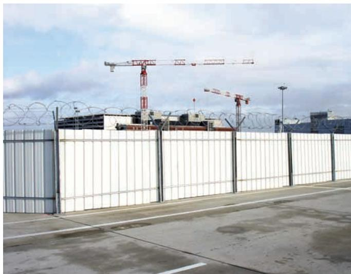
Clôture mobile composée de tôles planes galvanisées
