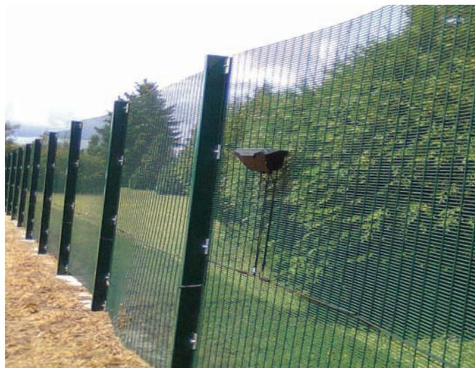
*Câble à détection de choc monté sur clôture en panneau soudé*
