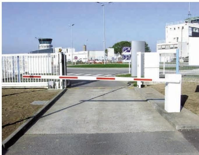
*Barrières levantes assurant le contrôle d'accès des véhicules*
