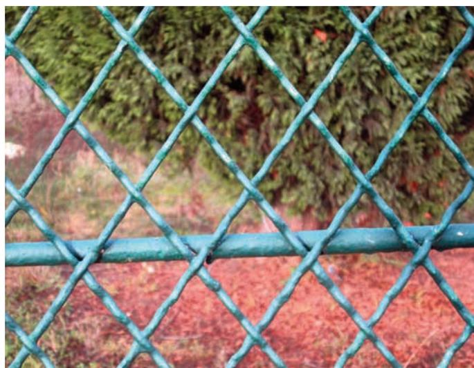
Grillage ondulé avec tubes horizontaux
