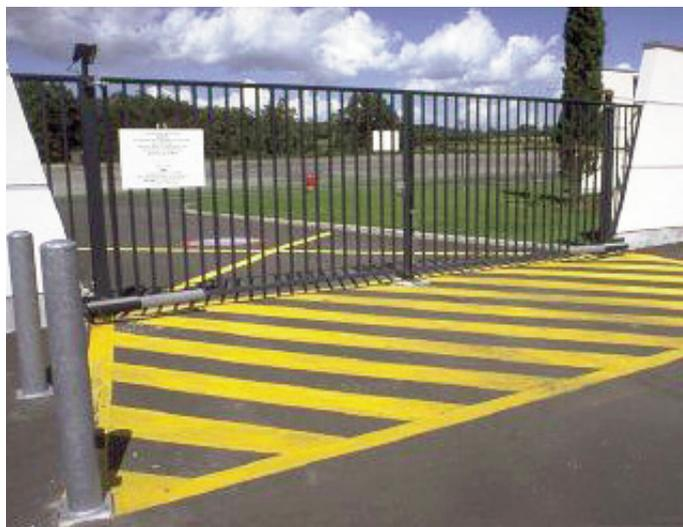
Portail pivotant avec un remplissage par barraudage
