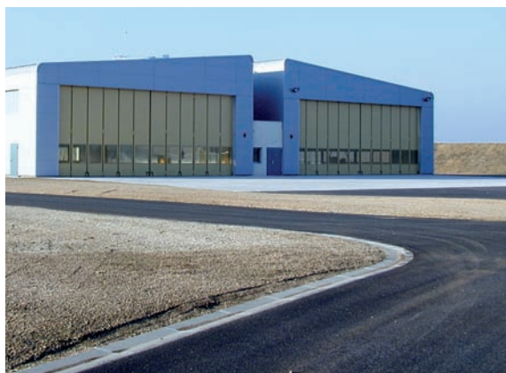
Hangar Rafale sur la base aérienne de Saint-Dizier
