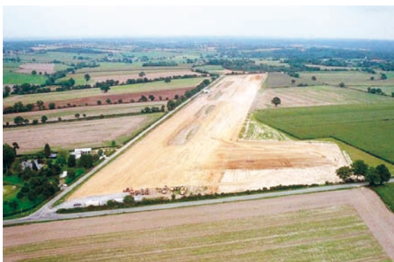
Le chantier de l'aérodrome de Saint-Sulpice-des-Landes conduit par l'ESBA du STAC
