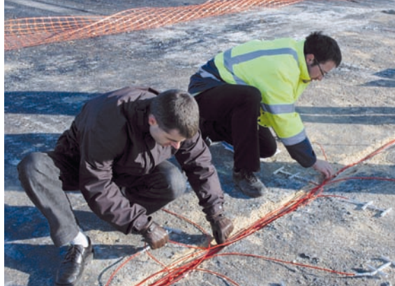
Pose des capteurs de mesure d'élongation (x,y) en base de grave bitume sur la chaussée expérimentale du STAC
