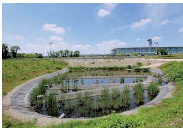
Aéroport de Bâle-Mulhouse : station d'épuration plantée de roseaux (rhizosphère)
