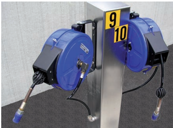
Borne de pompage de l'air destiné aux analyses
