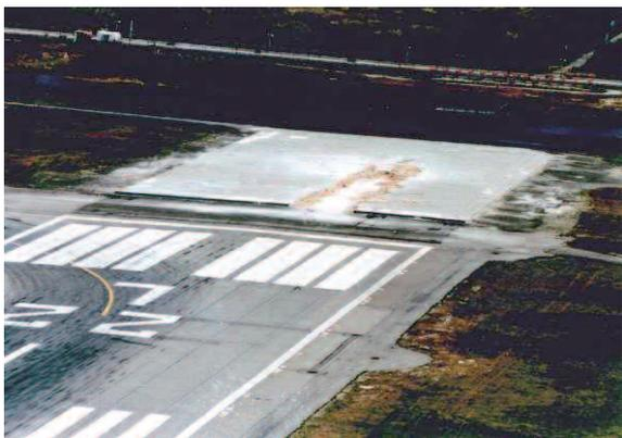
Aire d'extrémité de piste en béton cellulaire après arrêt d'urgence d'un avion
