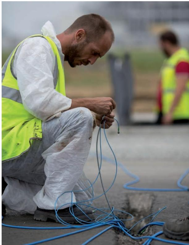
Mise en œuvre de capteurs optiques à Toulouse-Blagnac
