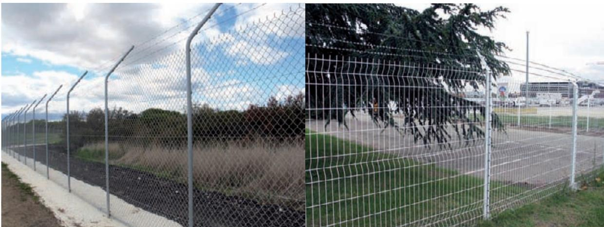
*Clôtures avec bavolet et enfouissement du grillage dans du béton*
