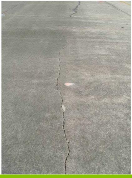
Fissure de degré de gravité élevée Départ de matériaux Ouverture >2mm Profonde
