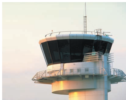
6 Les vitrages des vigies doivent être inclinés de 18° à 20° - BREST-GUIPAVAS
