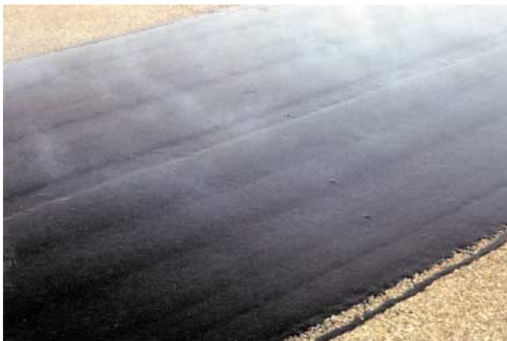
Aspect d'une membrane en bitume caoutchouc aussitôt après son répandage
