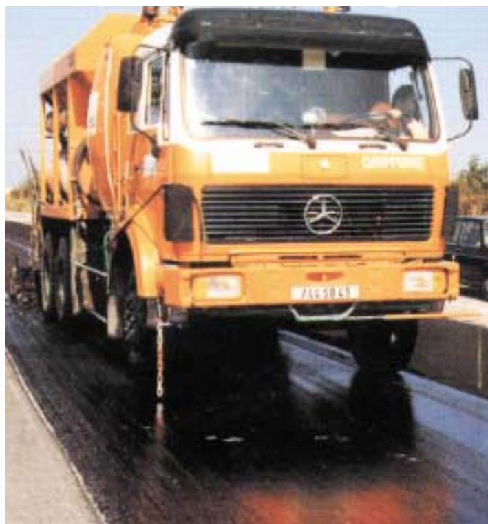
Mise en œuvre d'un enrobé coulé à froid pour protéger la membrane.
