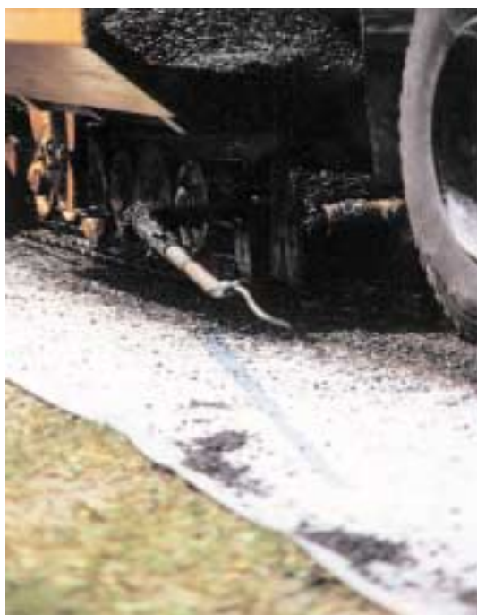
Mise en œuvre de l'enrobé sur le géotextile
