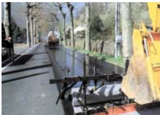
Mise en place du géotextile sur la couche d'accrochage
