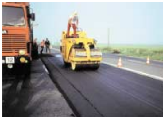
Compactage du sable enrobé antifissure
