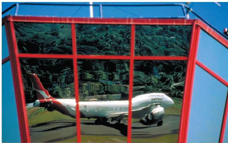
7 L'importance des angles de visibilité conduit à des vitrages de très grandes dimensions
